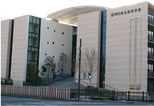
施工実績 川口市立高等学校 (2018年度)
