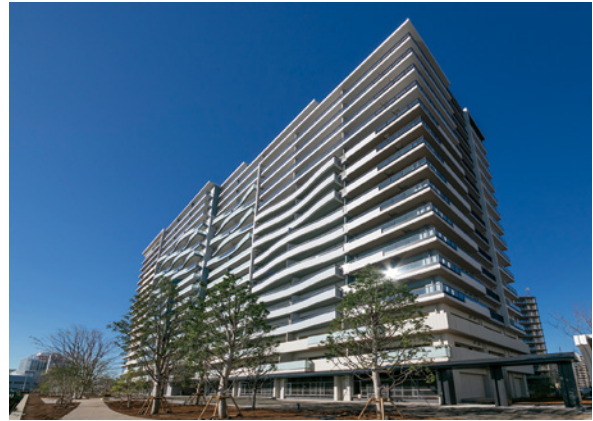
施工実績 晴海フラッグ (東京五輪選手村) (2024年度)
